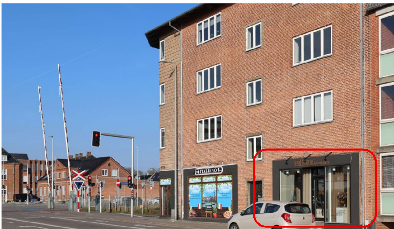
Facade set fra Frederiksberggade
